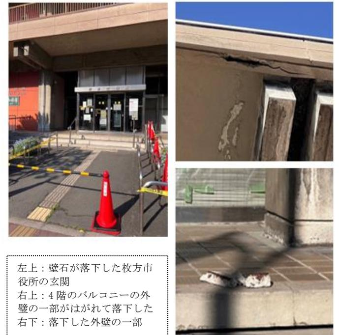
左上：壁石が落下した枚方市役所の玄関
